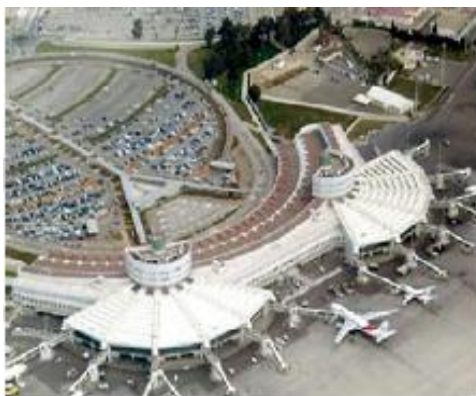
Aéroport International Houari Boumediene d'Alger.
